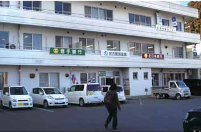
金融機関などが利用している旧山田病院
