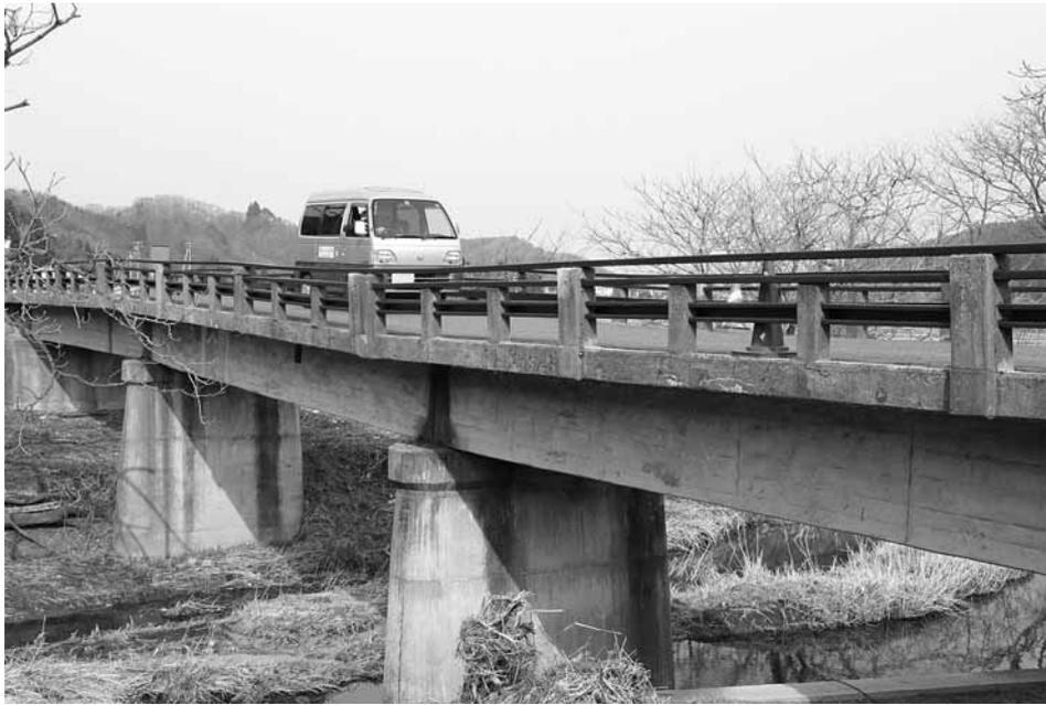
昨年12月の低気圧による大雨災害で橋面が20%沈下した馬指野橋。早急な復旧が望まれます
