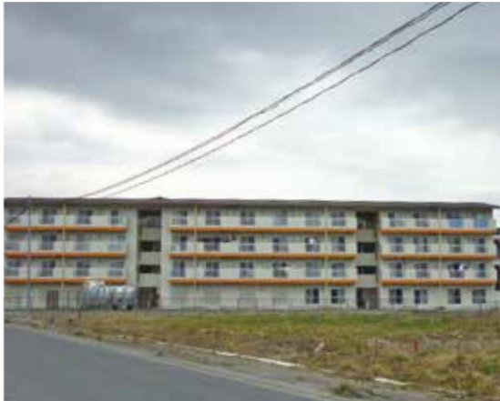
保証人の要件緩和が望まれます (柳沢災害公営住宅)
