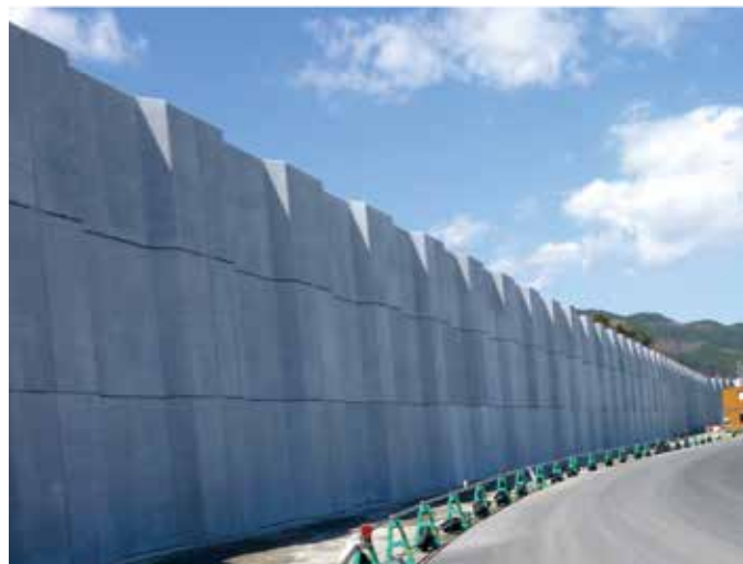
防潮堤の工事が進んでいます
