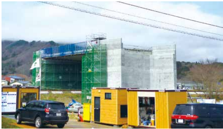
工事が進む県道宮古山田線
