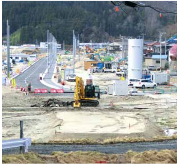
地盤改良工事が進む大沢地区の住宅団地
