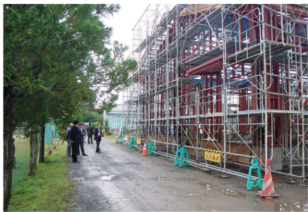
建設中の豊間根中武道場を視察
