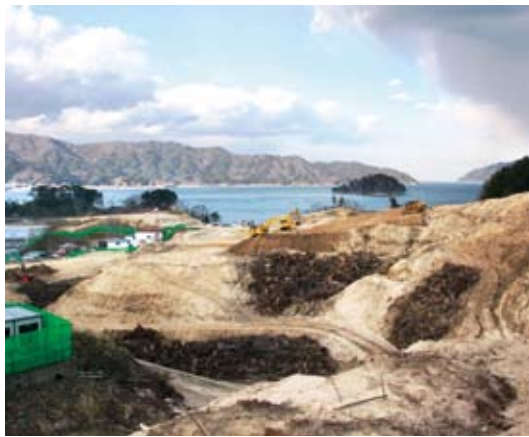
造成が進む織笠地区の高台住宅団地
