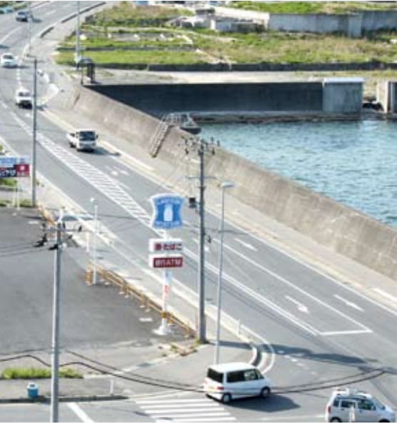
防潮堤整備予定地付近
