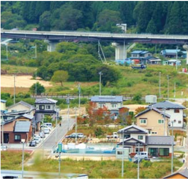
住宅再建が進んでいます（柳沢地区）
