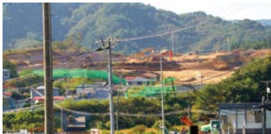
施工中の織笠地区高台住宅団地
