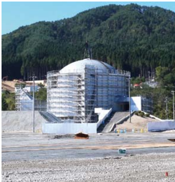
復旧工事中の鯨と海の科学館
