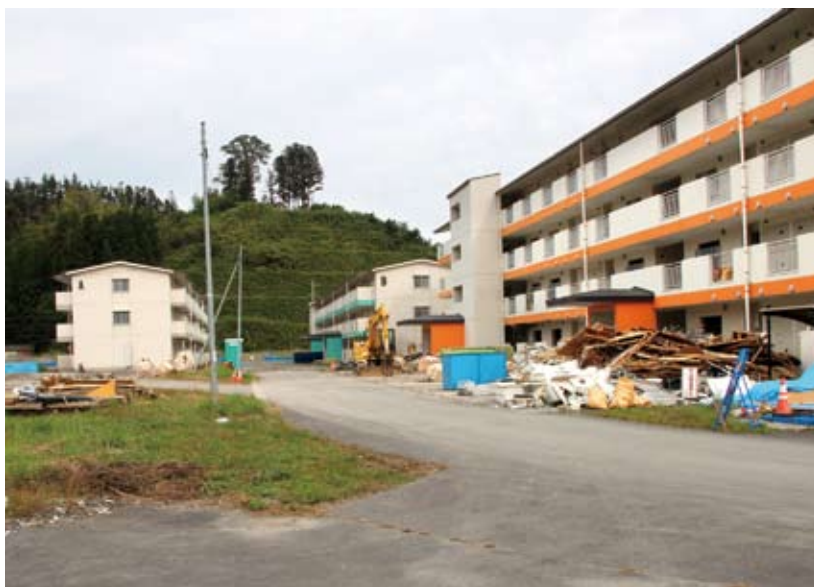
施工中の柳沢団地被災者向け公営住宅
