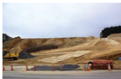
造成中の船越・田の浜地区第1団地
