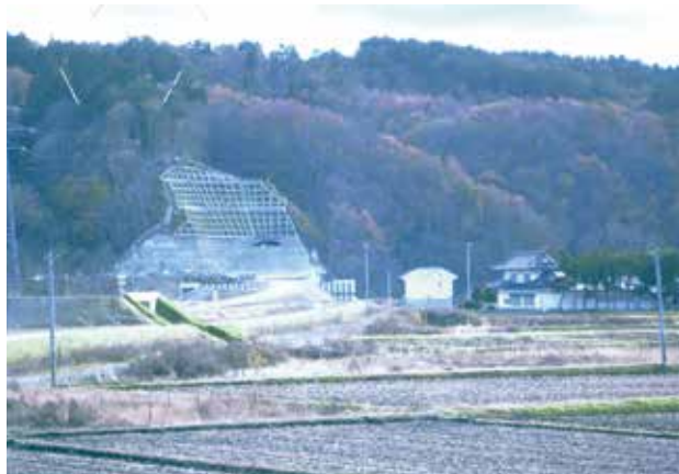
荒川地区の三陸沿岸道路
