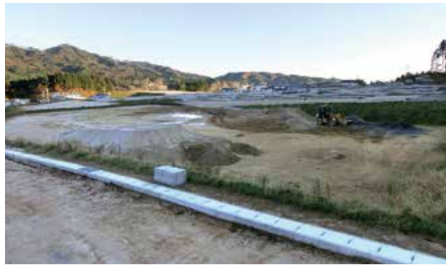
船越地区に造成中の高台住宅団地
