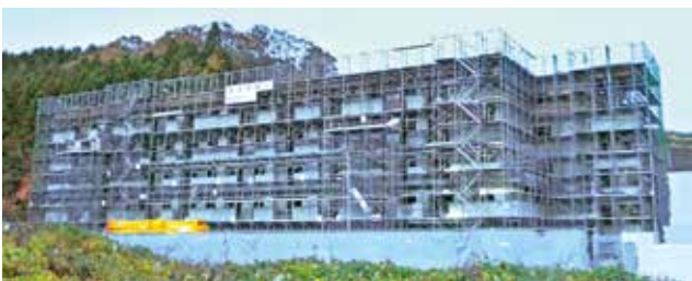
大沢地区に建設中の災害公営住宅
