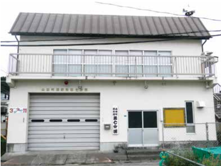
消防団は町の宝です (津波被害に遭うも修繕した第7分団屯所)
