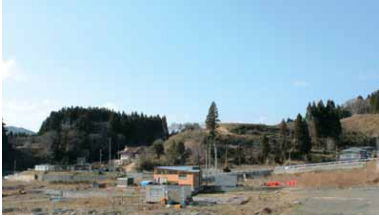
田の浜地区の高台住宅団地造成予定地
