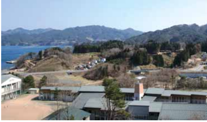
織笠地区の高台住宅団地造成予定地
