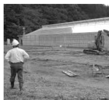
建設が始まった山田町堆肥センター出荷施設棟
