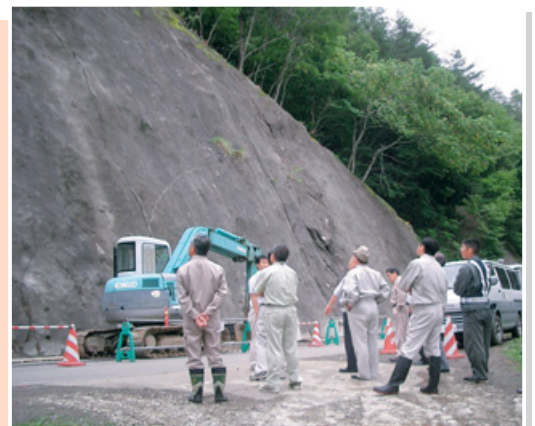
町道富士線法面災害防除工事の現地視察
