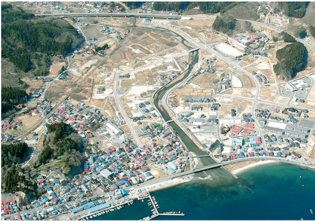
平成32年度完成を目指し整備が進められている 柳沢北浜地区土地区画整理事業（21年3月撮影）
