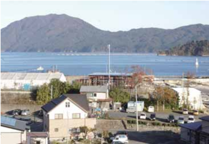
おぐら山にはNPO団体が 公衆浴場を建設中です (写真中央の鉄骨の建物)
