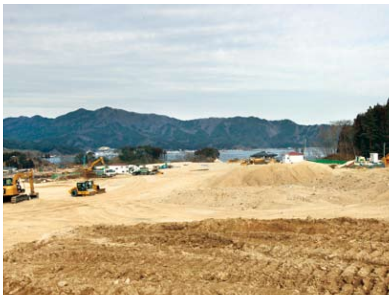
造成中の織笠地区高台住宅団地
