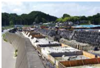
細浦の防潮堤工事現場
