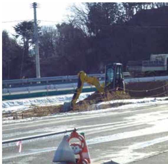
復旧事業における重機での作業風景
