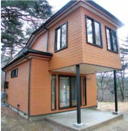
改修されたケビンハウス1号棟
