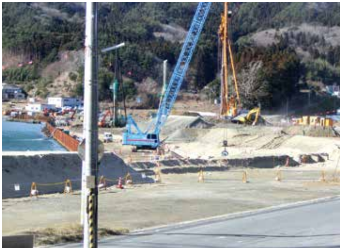
建設中の前須賀・タブの木荘線
