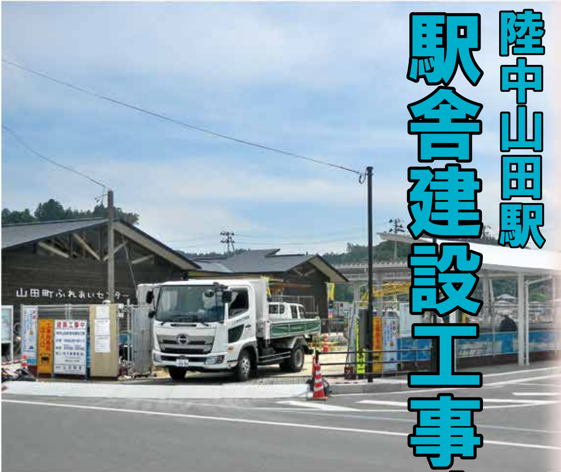
陸中山田駅駅舎建設予定地
