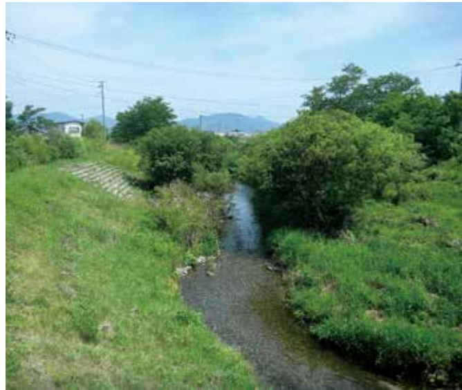
整備が待たれる関口川（北っ子橋下流側）
