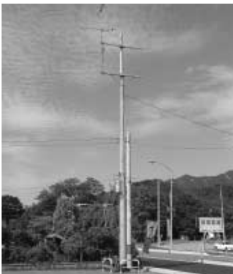
難視聴地域解消事業で設置された共同受信アンテナ（長内・嶋田・新田地区テレビ共同受信施設組合）
