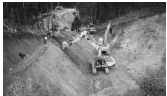
平成20年度の完成に向け工事が進められています(町道長林大浦線)
