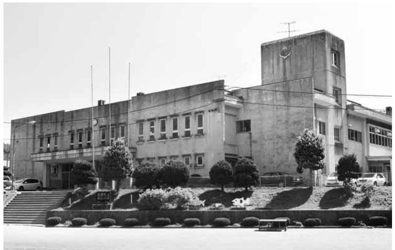
学校耐震化補強工事は船越、織笠、山田南、山田北、大沢の5つの小学校で実施されます(昭和50年に建設された織笠小学校)
