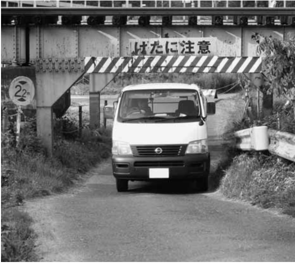
県の河川改修（関口川）に合わせて鉄橋下道路改修（桁下確保）を要望している町道沢田関谷線
