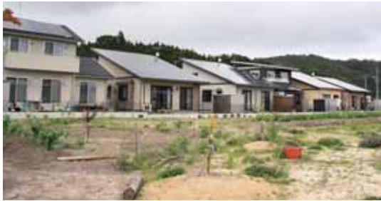
山田北小学校付近に自主再建した住宅
