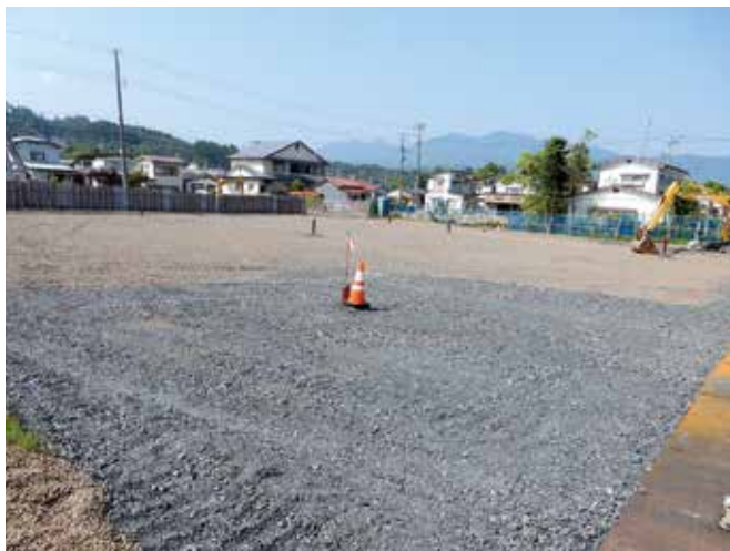
敷地造成が終わり建設が始まる災害公営住宅 (長崎第2団地)
