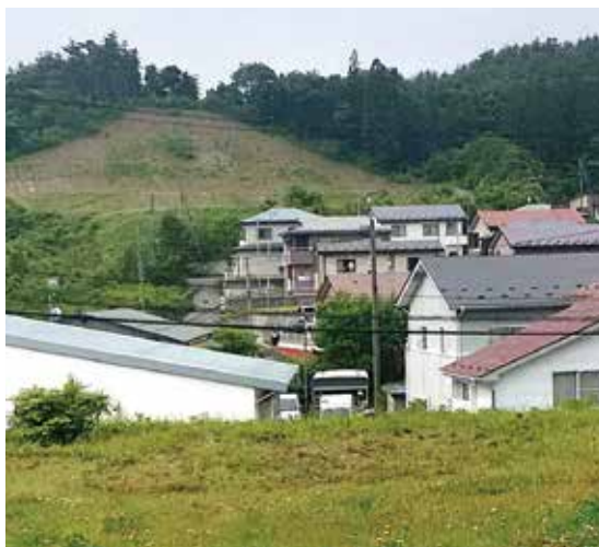
防火水槽設置が望まれる山谷地区
