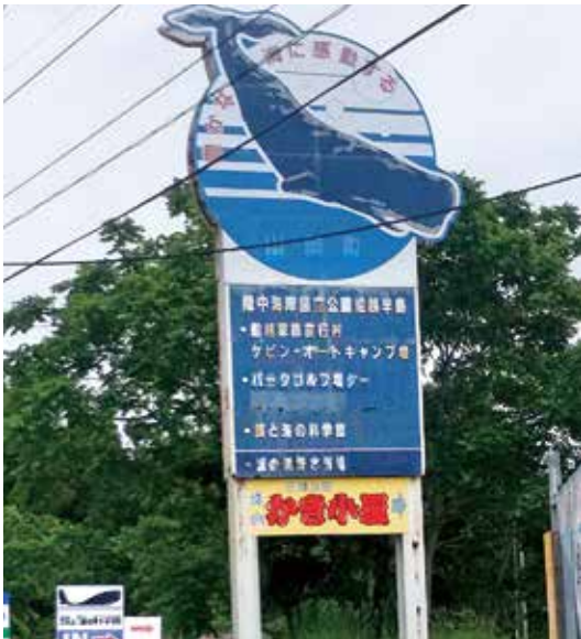
補修が必要な案内板
