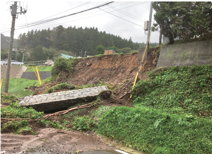
台風19号被害の様子
