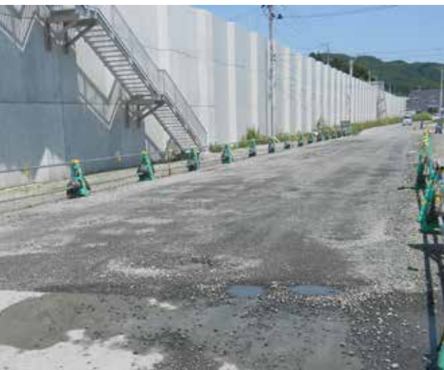
臨港道路の早期整備を（西川水門付近）
