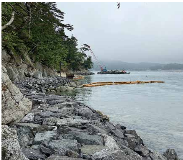
遊歩道工事が進むオランダ島
