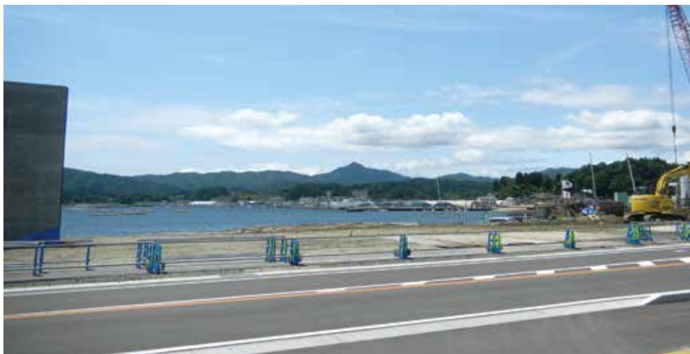
北浜地区の防潮堤建設予定地
