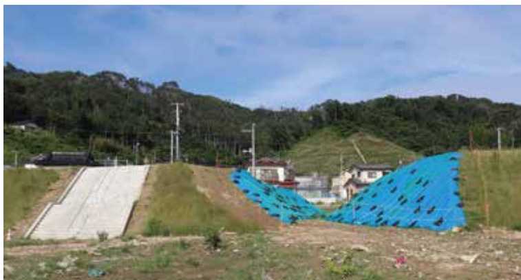
豪雨・津波対策のために車道整備が望まれます
