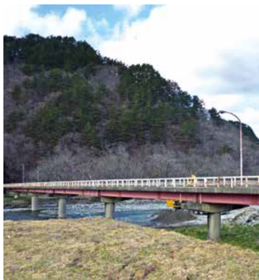
長寿命化修繕計画に基づき補修する繫橋
