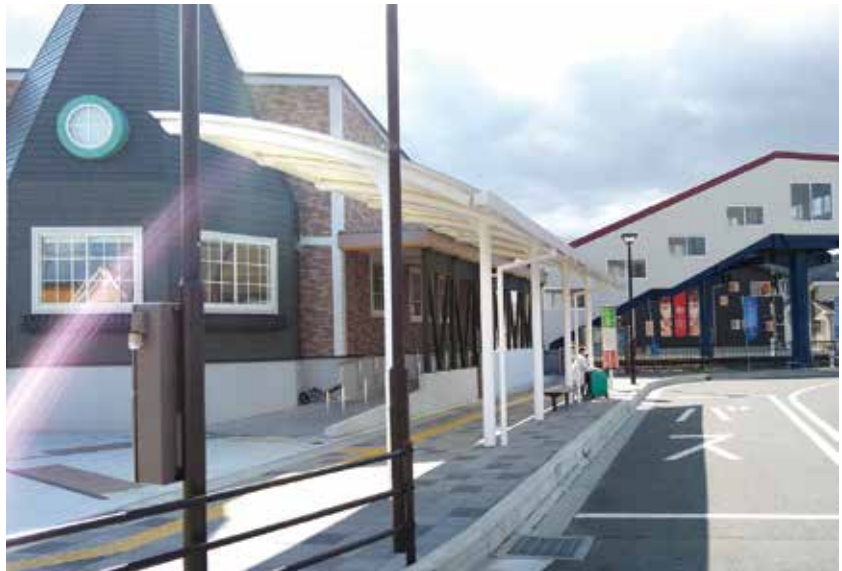
循環バスの起点となる陸中山田駅付近
