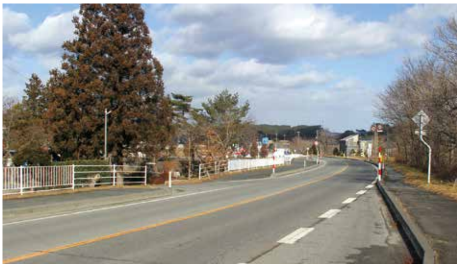
横断排水路が整備される豊間根地区の国道45号
