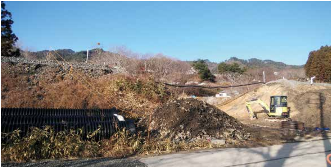
復旧が進む三陸鉄道
