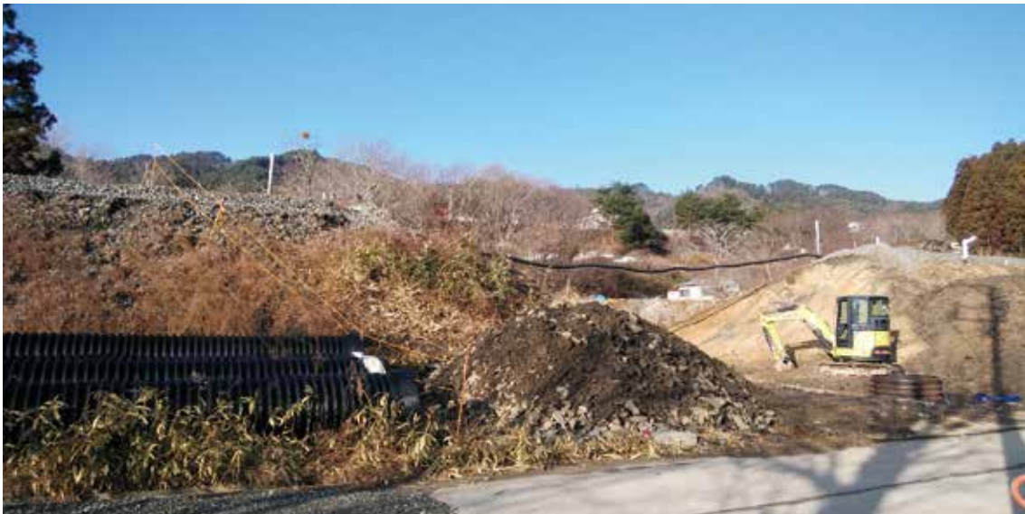
復旧が進む三陸鉄道
