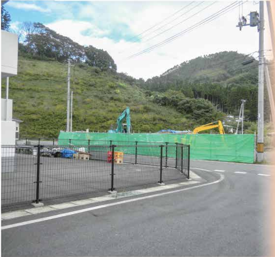
建設工事中の山田町消防団第2分団消防屯所
