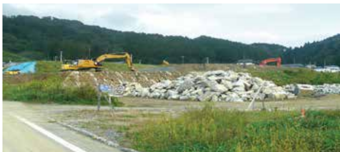
利活用が望まれる田の浜地区低地部
