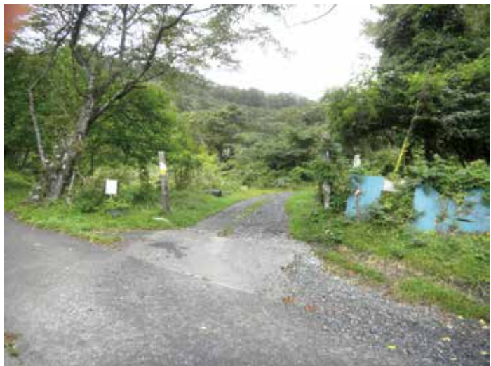
土石流が心配されるごみ処理場跡地
