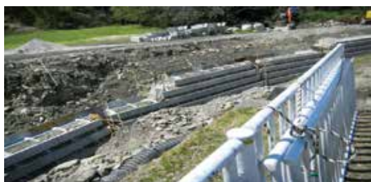
護岸復旧中の長内川（長内コミセン付近）
