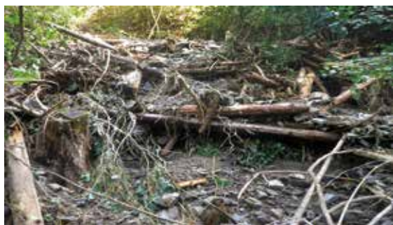
被災し土砂や流木が山積みになった女川上流部
