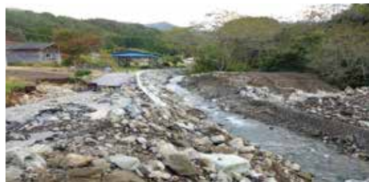
氾濫被害が発生した長内川
