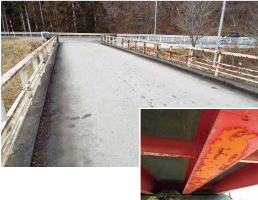
老朽箇所の補修や塗装の塗り直しが行われる繫橋
