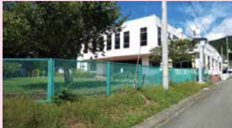
建て替え予定の豊間根生活改善センター（上）と大沢地区のふるさとセンター（下）
