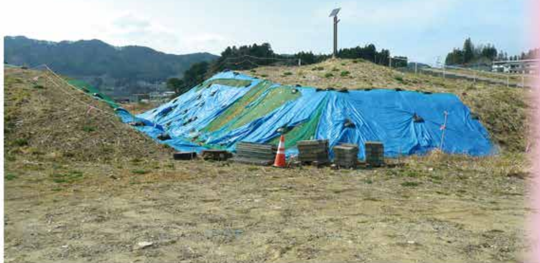
改良復旧が待たれる田の浜地区防災緑地公園
