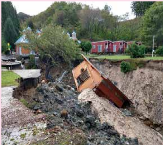
台風19号で大きな被害を受けたオートキャンプ場
