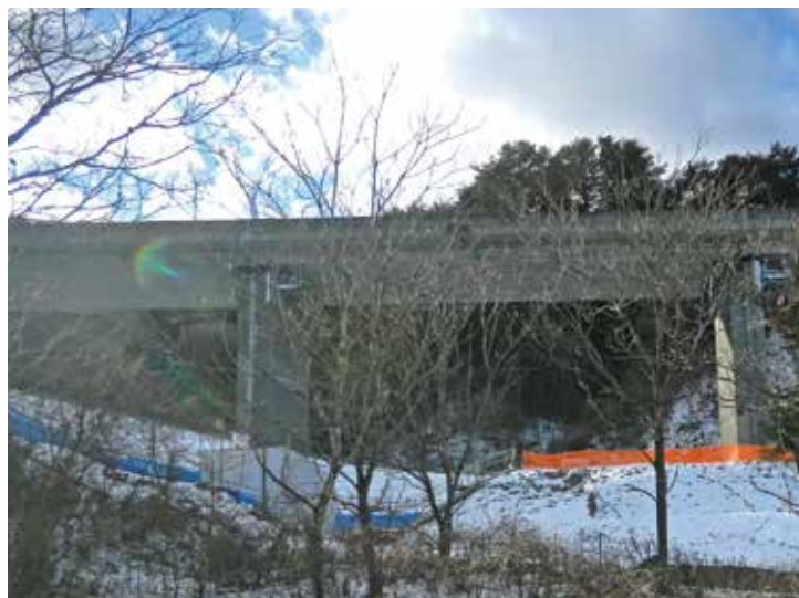
草木地区からの避難道として検討される箇所
