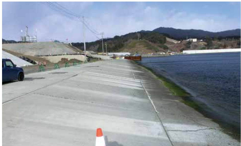
滑り材設置は漁業者の皆様の願いです
