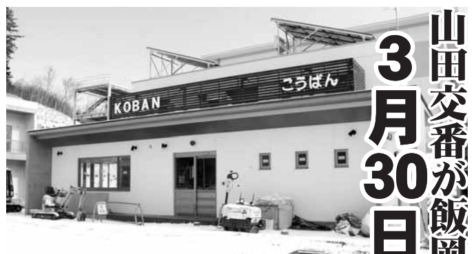
新設中の山田交番
