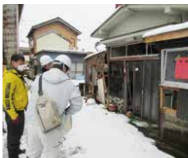
被災した家屋の調査を行う様子
