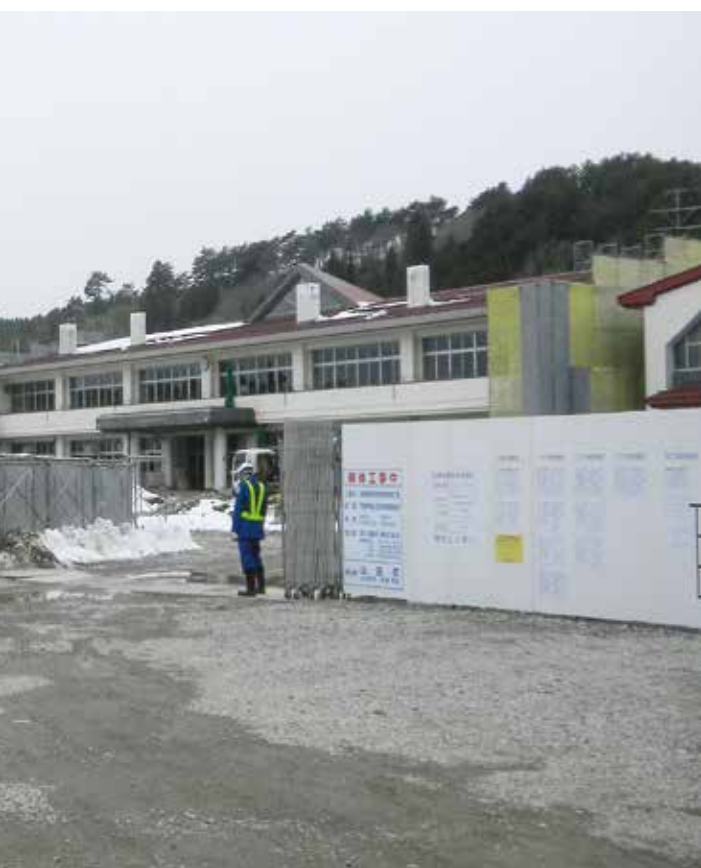
“希望ある利活用を”と期待される解体工事が進む旧豊間根中学校
