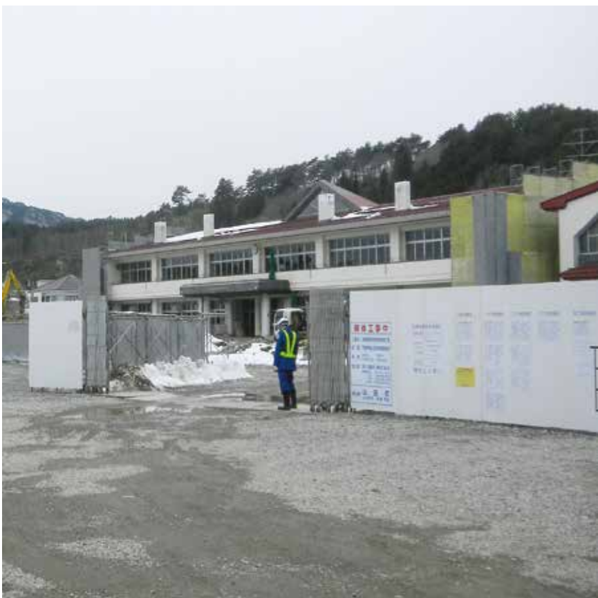
“希望ある利活用を”と期待される解体工事が進む旧豊間根中学校
