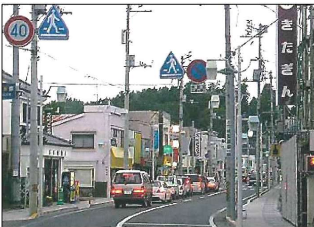
写真 山田町中心街（中央町、国道 45 号沿道）
