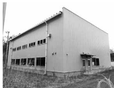
田名部工業団地産業復興棟E棟
