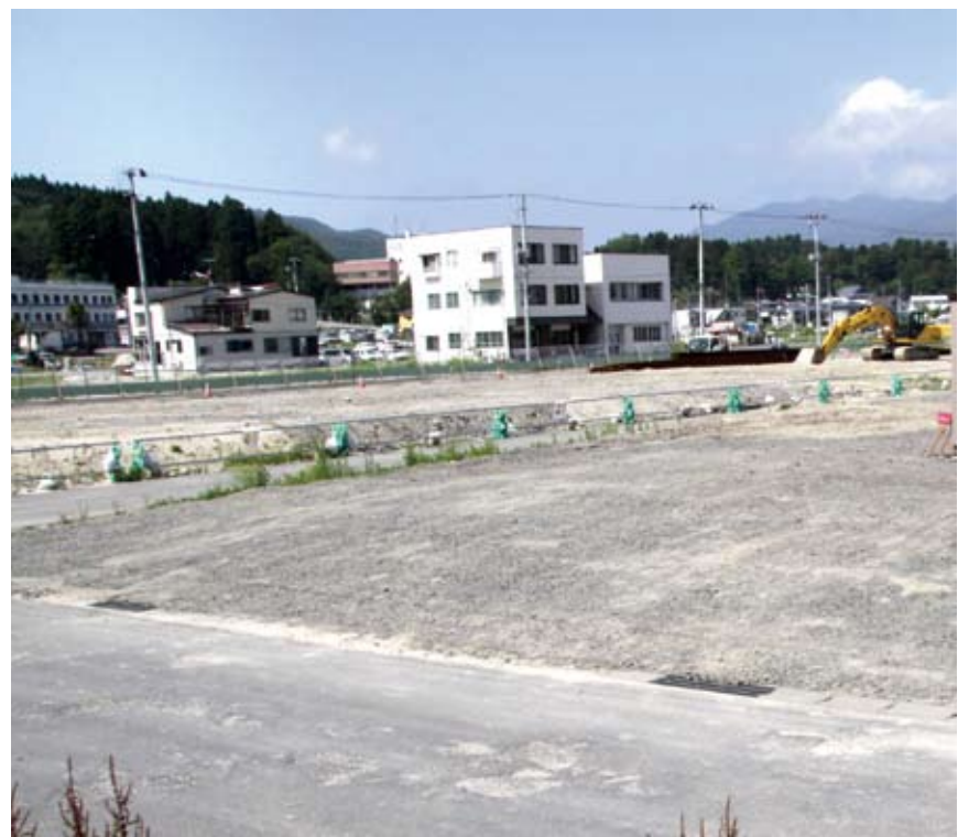
工事が進む長崎地区（町道細浦・柳沢線東側）
