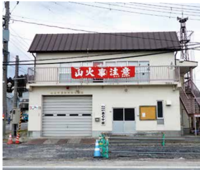
被災し老朽化する第7分団屯所の整備が望まれる
