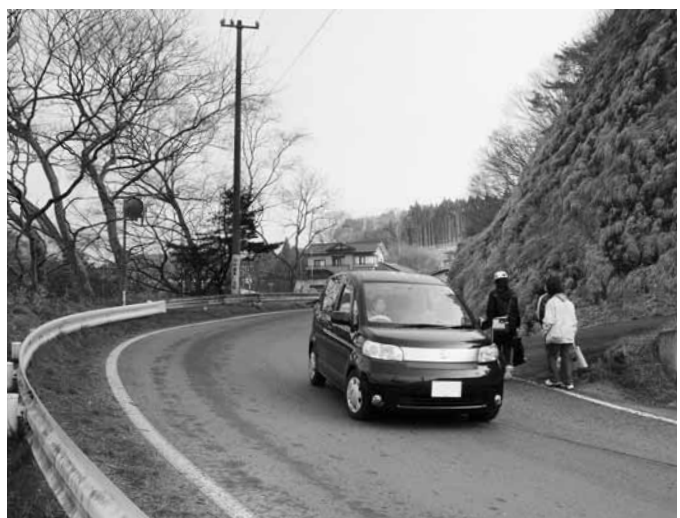
安全確保のため、早期の歩道設置が望まれる町道前須賀タブの木荘線（通称「どどっばな」付近）
