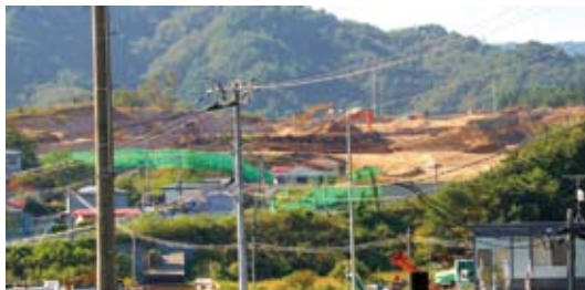
施工中の織笠地区高台住宅団地
