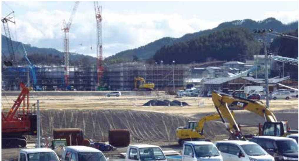
着々と工事が進む災害公営住宅山田中央団地
